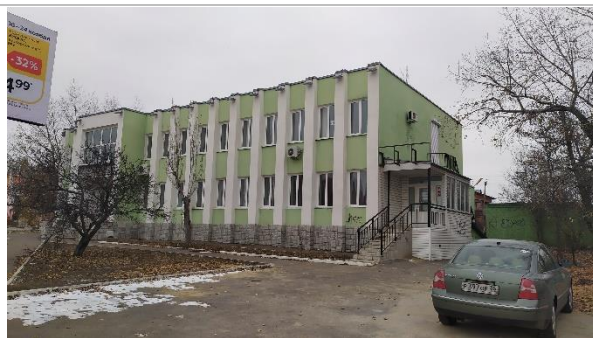
Фотография 3.1. Внешнее состояние нежилого помещения - основной части
